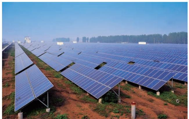
塌陷区治理后用作太阳能光伏电站
