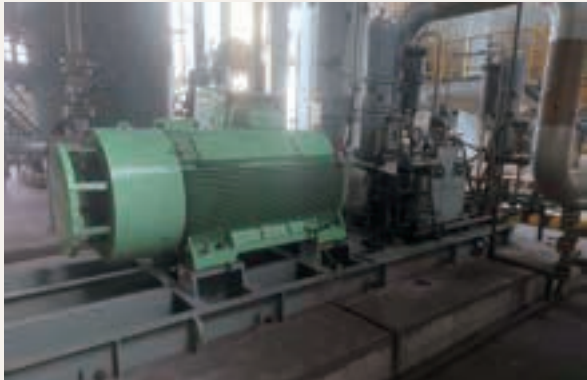
液力透平发电机组
