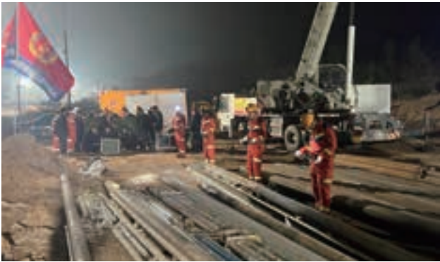
某煤矿冒顶事故救援现场
